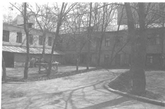
Левый угол двора со стороны арки накануне сноса флигелей
